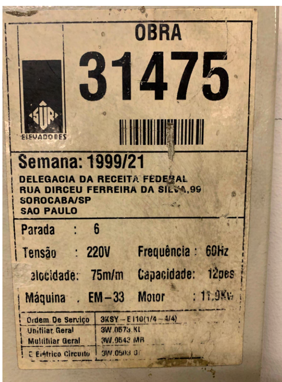
FOTO 09 – PLACA DE IDENTIFICAÇÃO DO QUADRO DE COMANDO
