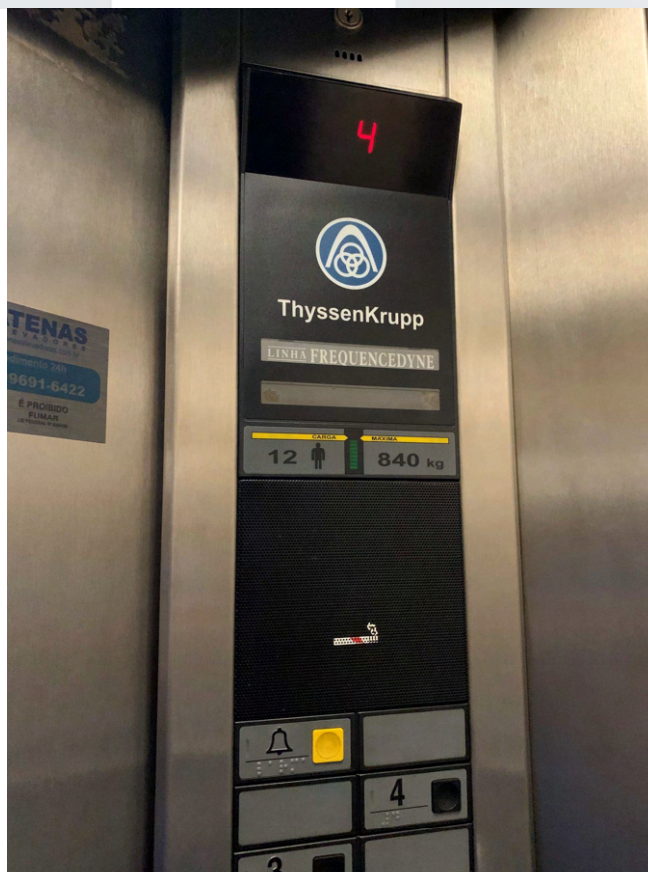
FOTO 14 – CABINE COM INTERCOMUNICADOR NÃO OPERACIONAL
