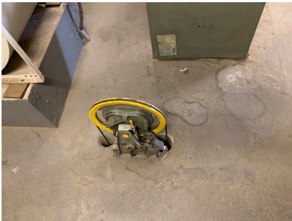
FOTO 06 - LIMITADORES DE VELOCIDADE DOS ELEVADORES
